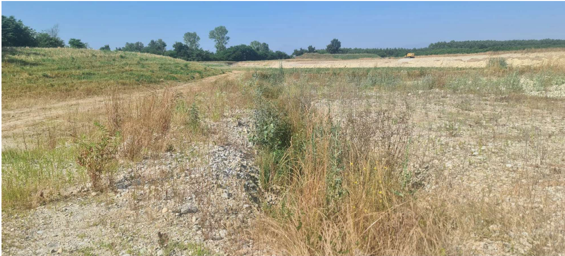
Figura 4-6 – la canaletta del lato orientale parzialmente inerbita ma in piena efficienza
