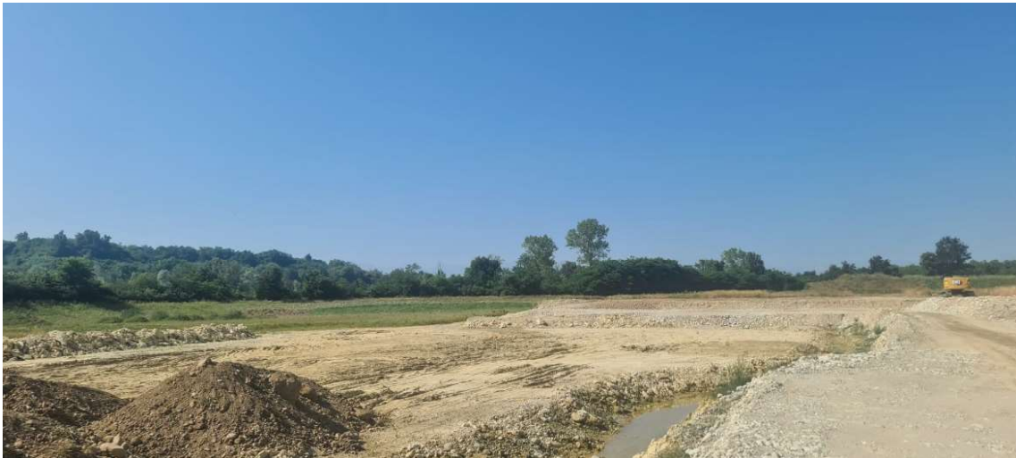
Figura 4-3 – A destra è ben visibile la canaletta transitoria alla base della scarpata atta a raccogliere le acque di deflusso
